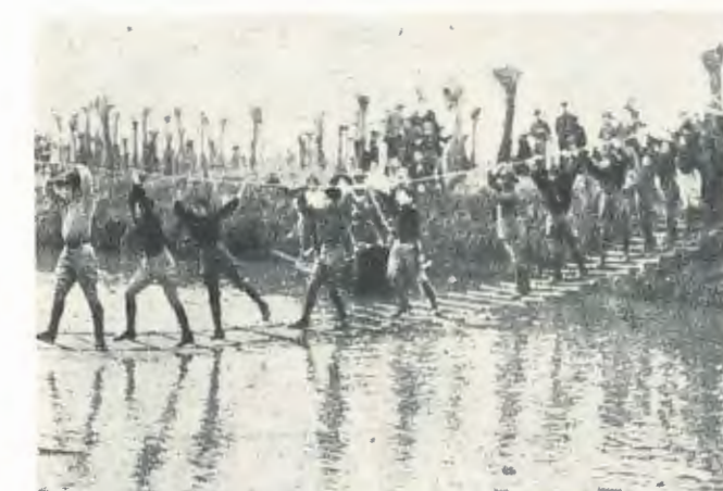
Passerella costruito dai G.E. veronesi.
